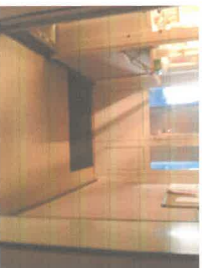
Термографический снимок 8. Дверь в тамбур. Износ уплотнительных элементов дверного блока. Характеристика температурных точек
